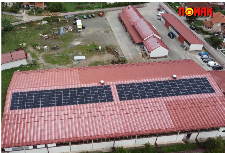
Слика 3. фотонапонска електрана на крову објекта
