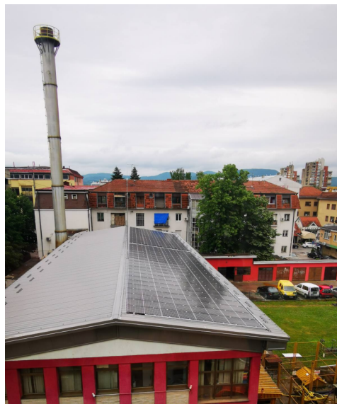
Слика 2. Изглед инсталисане фотонапонске електране на крову објекта „Централне котларнице“
